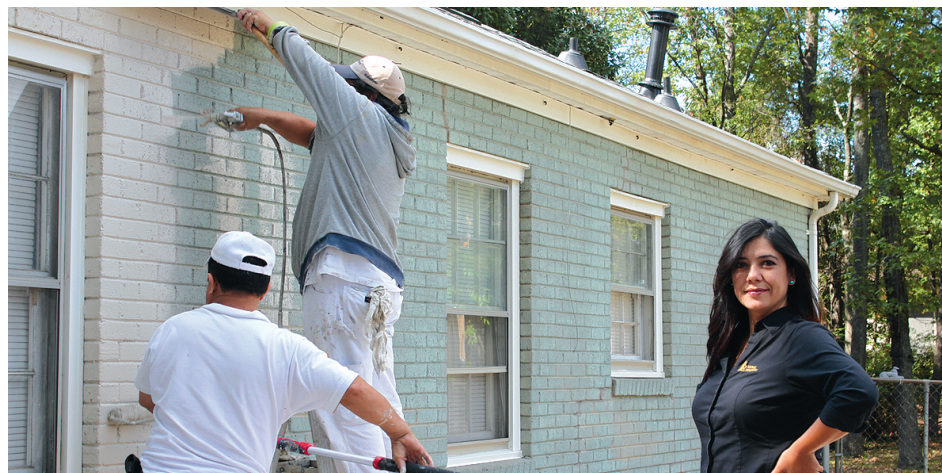
Millie Aguilar de Royal Roofing, dirige uno de sus proyectos de mejoras en una casa de Charlotte.
