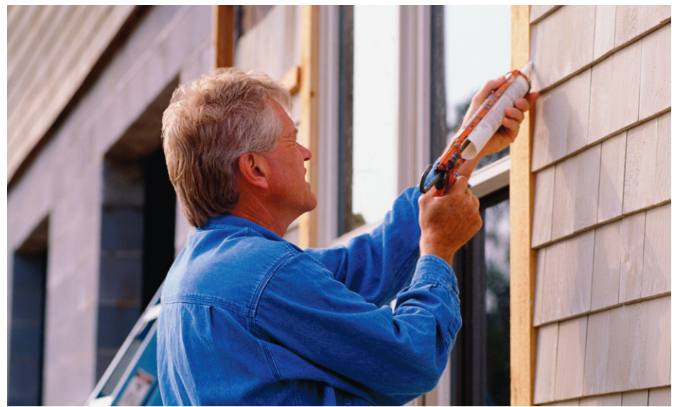
Al sellar la cubierta exterior de su hogar, se usa menos energía para calentar y refrescar la vivienda, por lo que se reduce la huella de carbono que dejan los sistemas de calefacción, ventilación y aire acondicionado, que gastan gran cantidad de energía.
